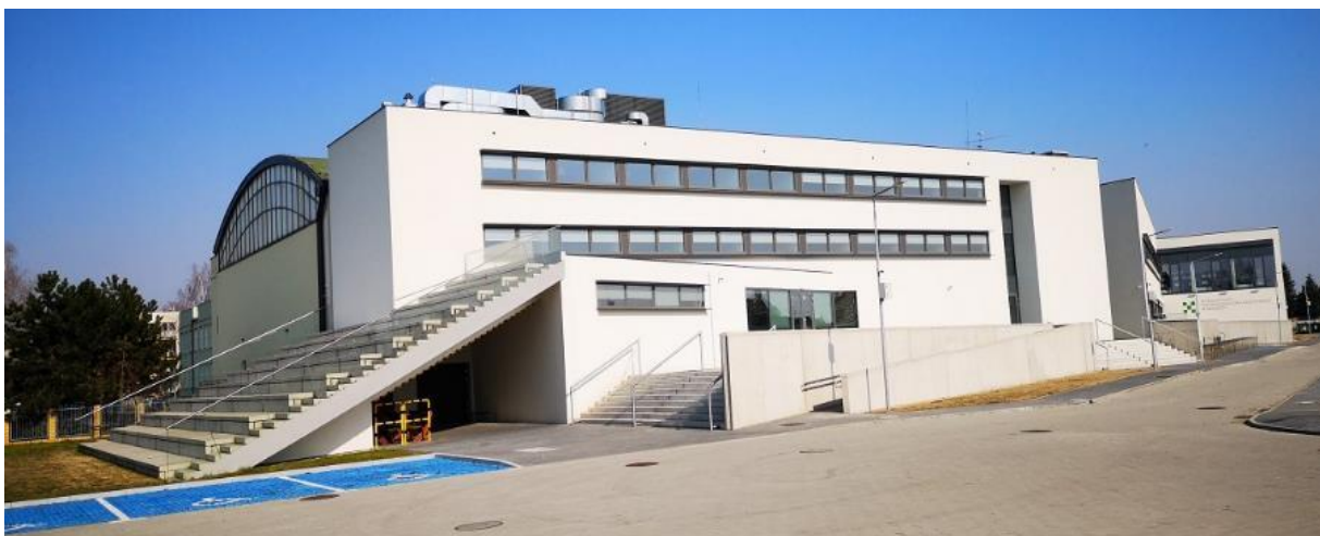
Fotografia. Centrum Kształcenia Praktycznego w Swarzędzu – dostępny podjazd wkomponowany w bryłę budynku i miejsca parkingowe dla osób z niepełnosprawnościami.
