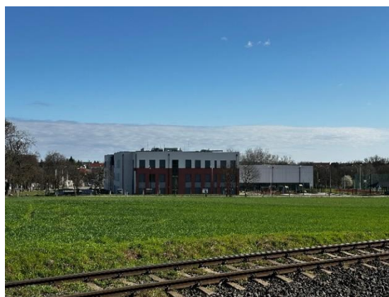
Widok teren szkoły – od strony południowo-zachodniej
