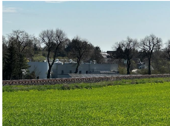
Widok na zabudowę ujęcia wody usytuowaną przy ul. Szyftera
