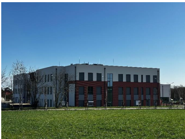
Widok na budynek szkoły od strony ul. Szyftera – na obszarze planu
