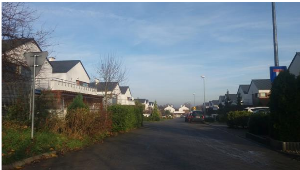
Fot. 5. Zabudowa mieszkaniowa przy ul. Parkowej w sąsiedztwie obszaru objętego projektem planu Źródło: własne
