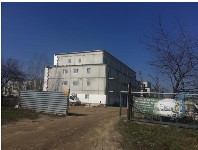
Zabudowa mieszkaniowa wielorodzinna przy granicy planu
