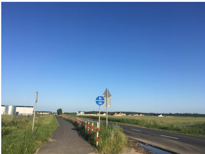
ul. Polna – droga powiatowa wzdłuż terenu opracowania
