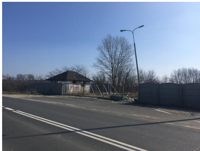
Zdewastowana zabudowa w sąsiedztwie planu
