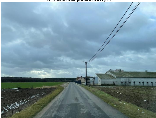
9. Widok na drogę gminną oraz zabudowę fermy drobiu w kierunku południowym
