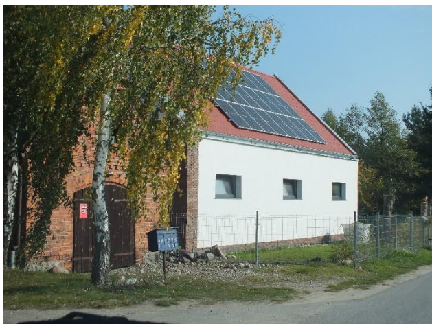
15. Południowo - wschodnia część obszaru opracowania – widok na skrzyżowanie w miejscowości Budziszewice
