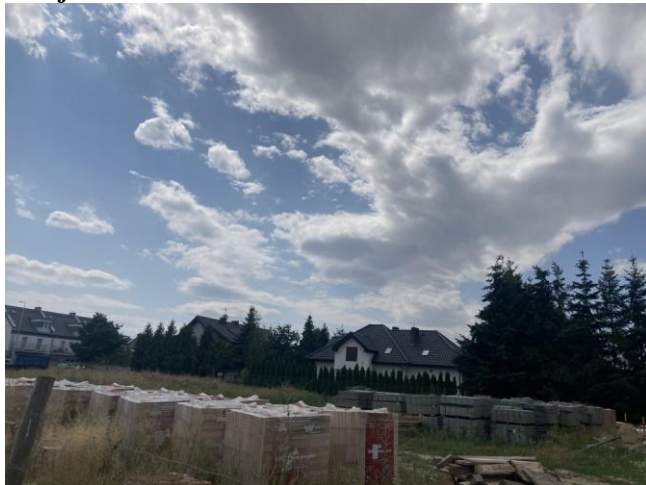
Materiały budowlane na działce nr 1980
